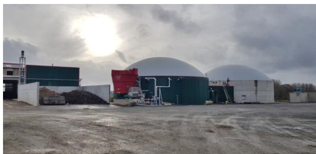
La centrale de méthanisation. Photo: France Biogaz
